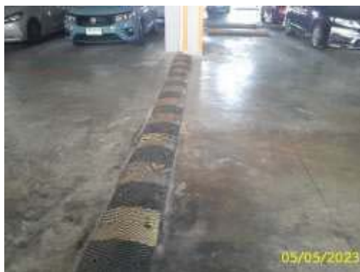
อุปกรณ์ชะลอความเร็ว ภาพที่ 2.2-3 การบริหารจราจร
