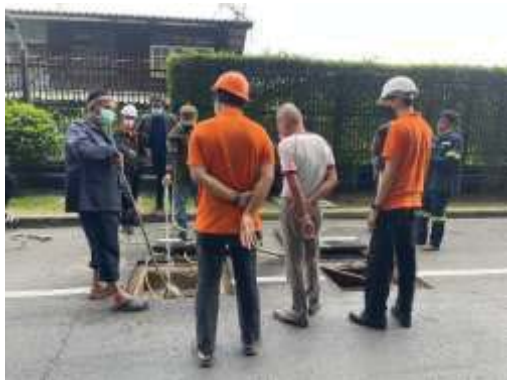
สูบลาก่อน และไข่มันระบบบำบัดน้ำเสีย
