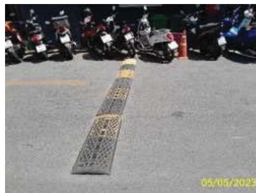
อุปกรณ์ชะลอความเร็ว ภาพที่ 2.2-3 การบริหารจราจร
